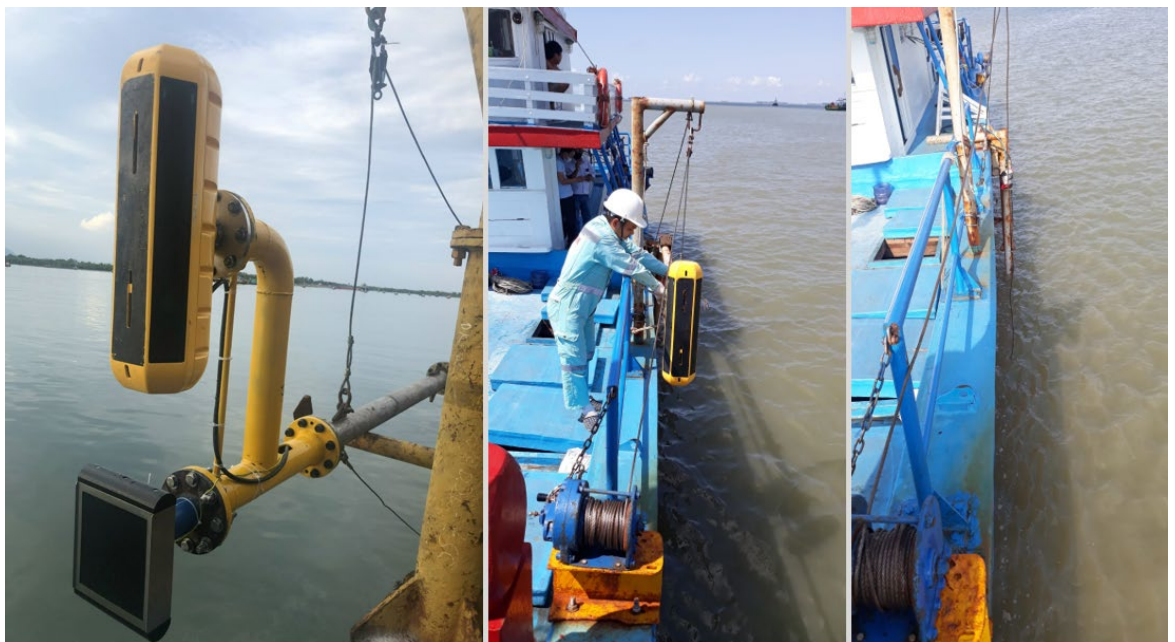
Hình 13: Lắp đặt trên mạn tàu
